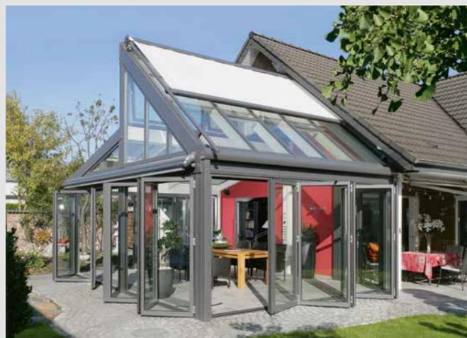
Moderne GEWE-therm® Verglasungen für Fenster und Fassaden erfüllen heute mehrere Funktionen gleichzeitig: Sie sorgen für Tageslicht und Ausblick, sind an der passiven Solarenergiegewinnung beteiligt, weisen geringe Wärmeverluste auf und ermöglichen im Sommer große Luftwechselraten zur Auskühlung des Gebäudes.
