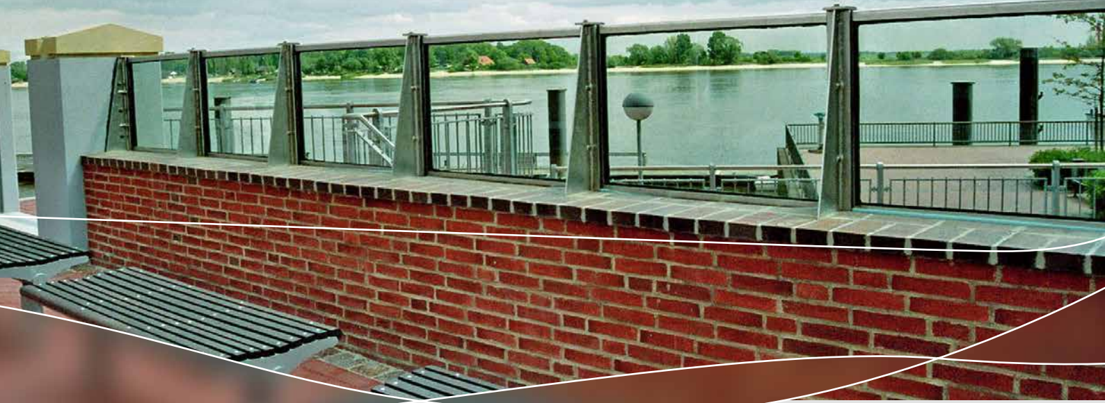
Hochwasserschutz aus Glas
