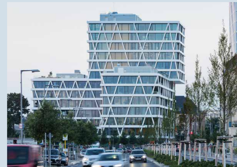
UNTERNEHMENSZENTRALE 50HERTZ IN BERLIN Eine funktional variable Fassadenverglasung von SCHOLLGLAS mit GEWE-therm® aus GEWE®-safe und GEWE®-dur H sowie GEWE®-safe aus GEWE®-dur und GEWE®-dur ESG-H mit Siebdruck.
