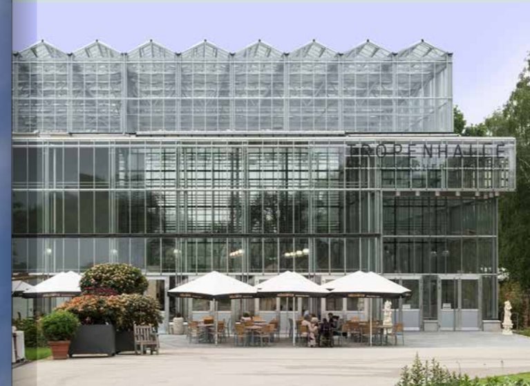
TROPENHALLE BALINESISCHER GARTEN IN BERLIN Eine Glashülle mit GEWE-therm® flora stellt ideale Bedingungen für maximale Licht- und UV-Transmission sicher.
