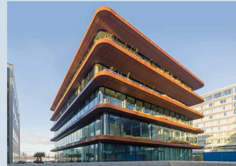
BÜRO- UND GESCHÄFTSGEBÄUDE DANZIGERKADE 207 IN AMSTERDAM, Niederlande Die komplexe Verglasung mit gebogenen Ecken und schwimmenden Fenstern besteht aus dem Sonnenschutz-Isolierglas GEWE-therm® sun.
