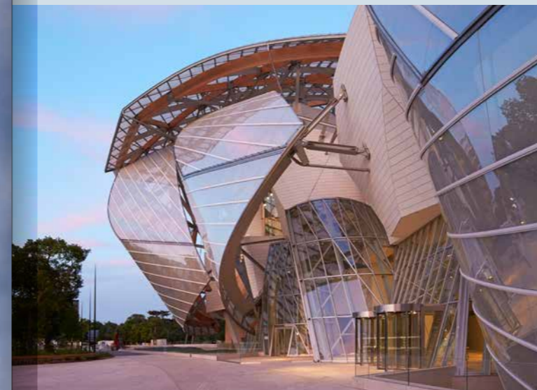
FONDATION LOUIS VUITTON IN PARIS, Frankreich Durch die Verwendung der Sicherheitsgläser GEWE-tvg® und GEWE-dur®-H erfüllen die fertigen Verbundsicherheitsgläser hohe konstruktive Anfor- derungen sowie sämtliche aktiven und passiven Sicherheitseigenschaften.
